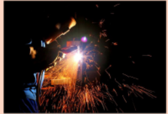
绽放 杭安公司 叶青/摄
