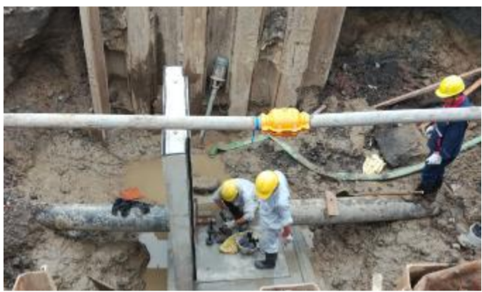
接,将所有接缝密封,防水砂浆锚固,最后进行注浆。W17 号检查井的成功拼装预示着本次杭州市华中路工
